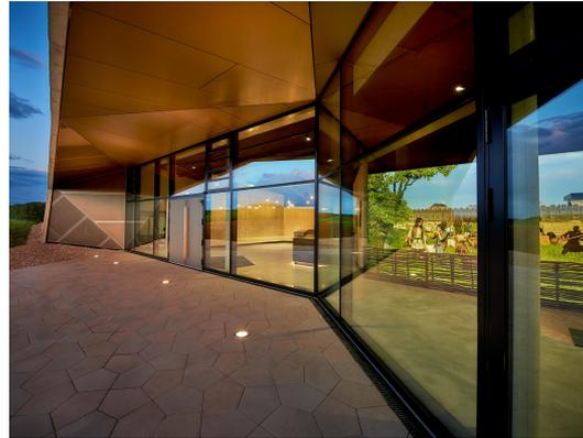
Eingangsbereich mit unter der Stahlbetonauskragung abgehängten Fassadenelementen aus Edelstahl
